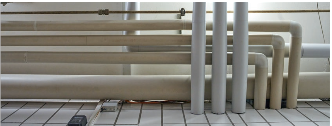
Neue Verrohrung, maßgeschneidert und gut in den Bestand integriert.
