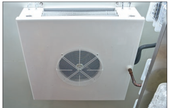
Luftkühler, speziell ausgelegt für hohe Drucklagen.
