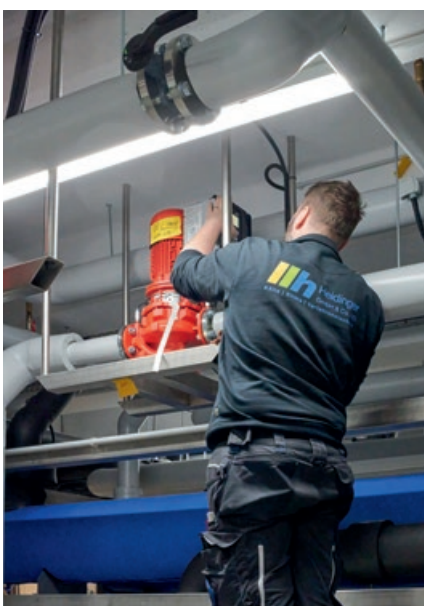
Experte am Werk: Markus Roschitz bei der Einregulierung des Kühlwassersystems.
