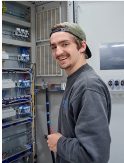
Noah Haug beim Finish der Steuerungstechnik.
