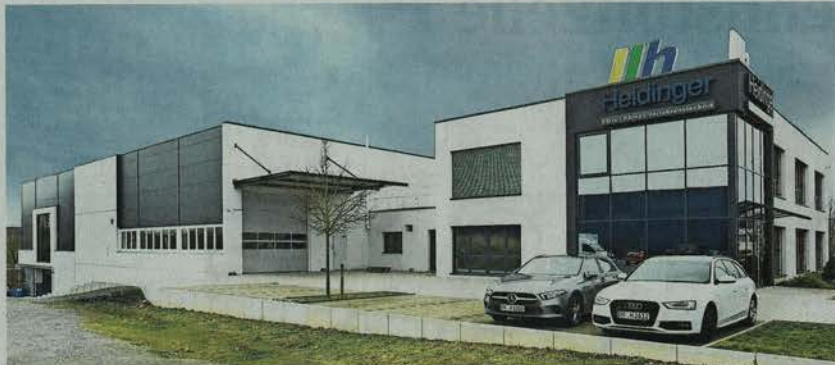
Die neue Fertigungs- und Lagerhalle (links).
