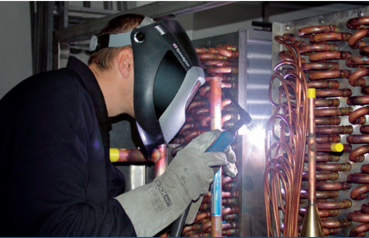
Arbeiten mit dem Schweißgerät
